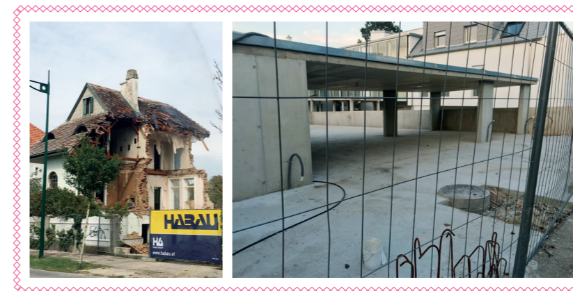
Abriss eine Gründerzeit-Villa mit Garten in der Guntramsdorferstraße – stattdessen maximale Bebauung des Grundstücks und völlig zubetonierter Garten
