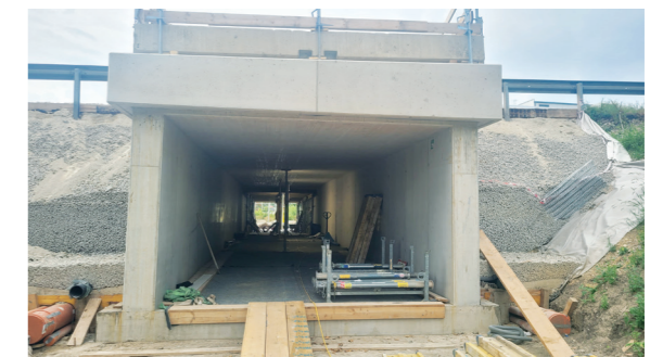
Blick von der Heidesiedlung durch die fertige Tunnelröhre zum campus21.
